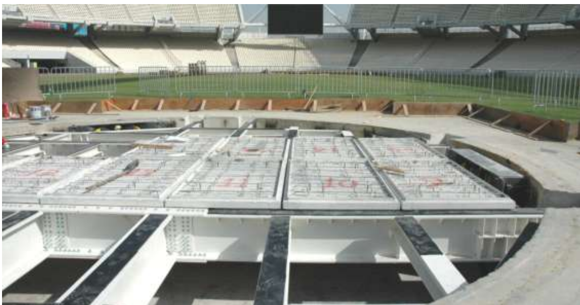
Φρέαρ τελετής έναρξης Ολυμπιακών Αγώνων στο κέντρο του αγωνιστικού χώρου του Ολυμπιακού Σταδίου. Διακρίνονται οι οδηγοί του ανελκυστήρα μεταφοράς φορτίων και η μεταλλική κατασκευή κάλυψης της οροφής του φρέατος.
